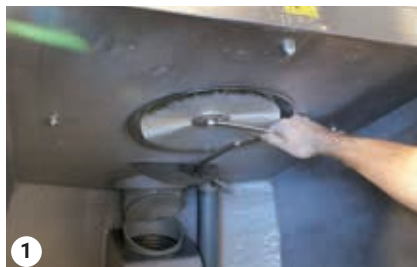
1 Demontáž rotačního filtru
